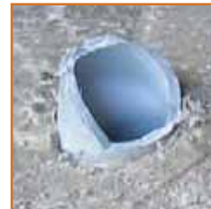
Broken conduit on jobsite
