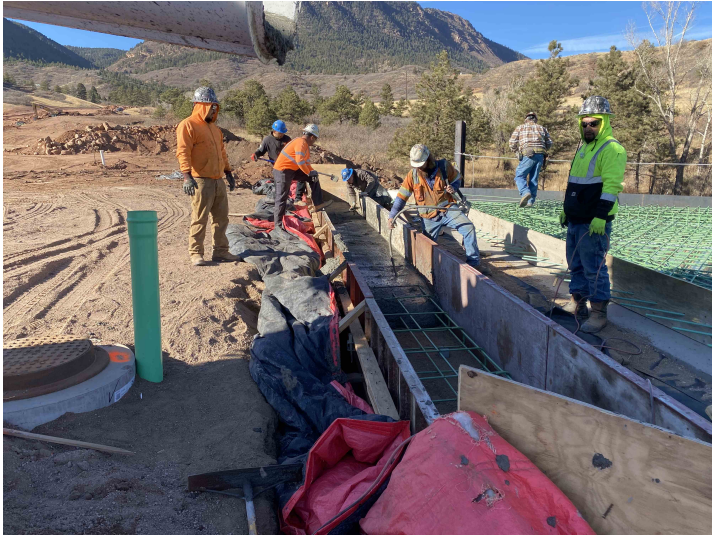
Pour on sleeper pad in progress
