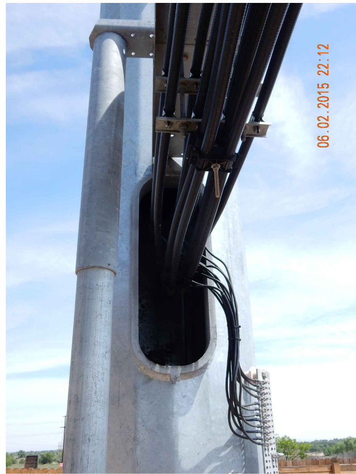
EXTERIOR VIEW: CABLE ENTRY AT MONOPOLE SCALE: N.T.S.
