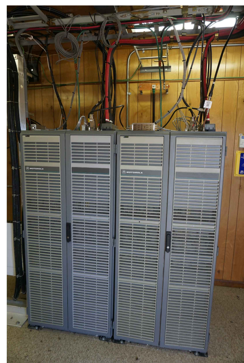
INTERIOR VIEW: SC4812'S SCALE: N.T.S.
