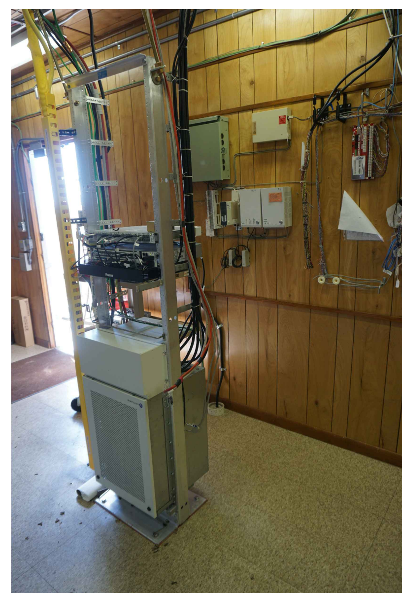
INTERIOR VIEW: E-NODE B/BBU RACK SCALE: N.T.S.
