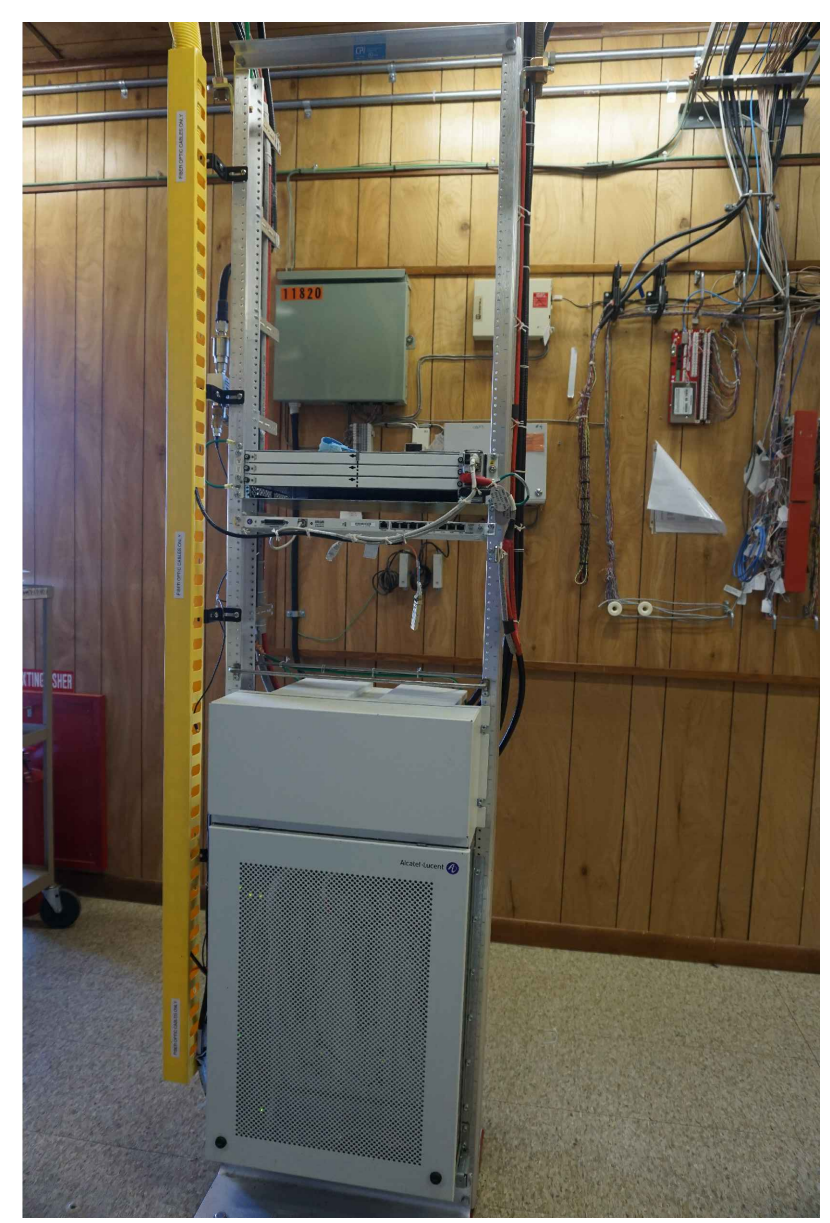
INTERIOR VIEW: E-NODE B/BBU RACK SCALE: N.T.S.
